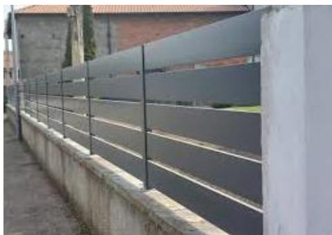
I parapetti delle logge e dei terrazzi saranno realizzati in ferro a doghe orizzontali con disegno curato dall'Impresa (in alternativa il parapetto dei balconi sarà realizzato con elementi verticali). Tutte le opere in ferro saranno vernicate con una mano di antiruggine e due mani di smalto RAL di colore a scelta della Direzione Lavori.
