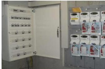
N° 1 Centralino generale, posto internamente all'alloggio nelle immediate vicinanze della porta di ingresso, di sezionamento e protezione completo di interruttore magnetotermico-differenziale attivo a sezionare l'impianto elettrico per la linea di illuminazione e linea prese, nonché a servizio delle varie utenze.
