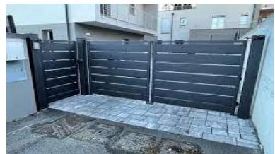
Il cancello di ingresso carraio sarà realizzato in ferro a disegno semplice a doghe orizzontali, con apertura del tipo scorrevole completo di motorizzazione elettrica con comando a distanza (telecomando bicanale in numero 1 per unità abitativa)
