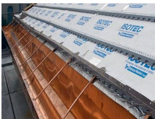
La coibentazione della copertura sarà realizzata all'estradosso del solaio in pendenza di copertura con un pannello di **POLIURETANO 10 cm tipo ISOTEC** o materiale equivalente escluse le zone di porticato e cornicione. Le pareti esterne saranno coibentate con sistema a "cappotto" di tipo EPS additivato con graffite di spessore 14 cm rifinito con intonachino colorato in acril-silossanico.
